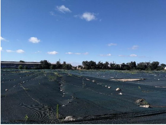
a. 拆除空地方位东
