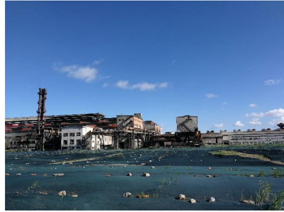
d. 拆除空地方位南
