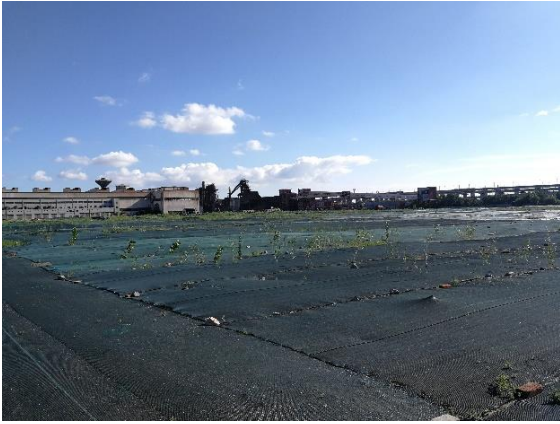
c. 拆除空地方位西
